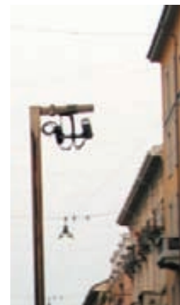
Pronte all'azione Una delle telecamere appena installate DNEWS
