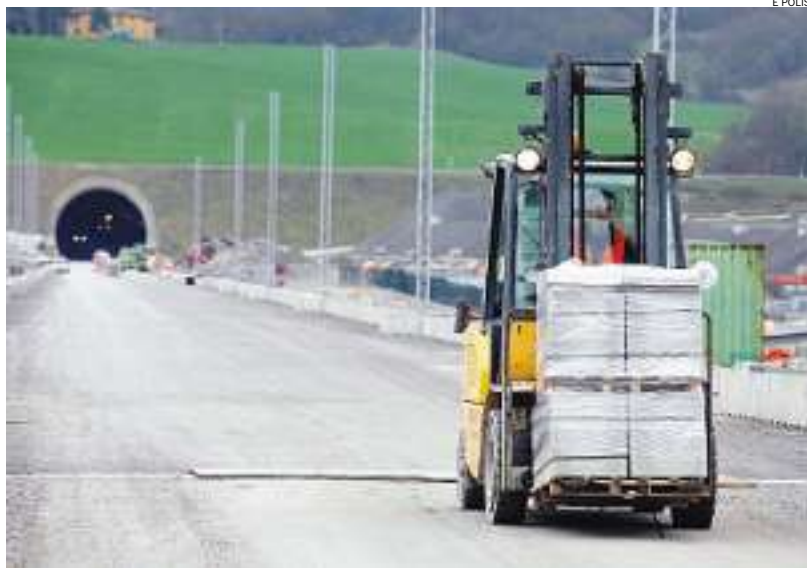
Un cantiere per la Tav
